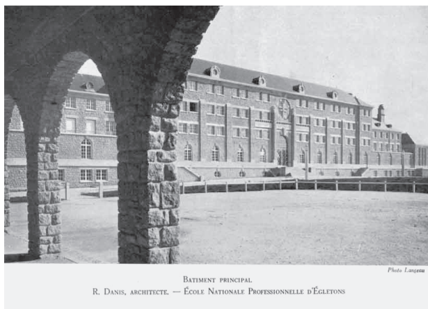
Ill. 6 : école nationale professionnelle d'Égletons, corps de bâtiment principal abritant l'administration, les amphithéâtres et l'internat, 1933 (Robert Danis, architecte) Source : L'Architecture , 15 avril 1937 (phot. Langeau).
